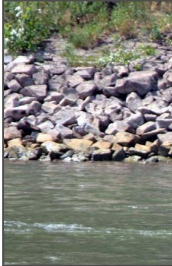
Steine, die zur Befestigung der Uferböschung aufgeschüttet sind. Sie dienen dem Schutz des Ufers vor Auswaschungen durch die von der Schifffahrt verursachten Wellen. Sie können eine nur schwer überwindbare Hürde für Schwimmer darstellen, die an Land gelangen möchten.
