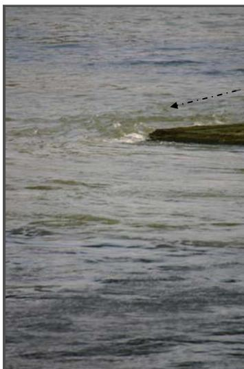
Strömungsabriss an einem Brückenpfeiler
