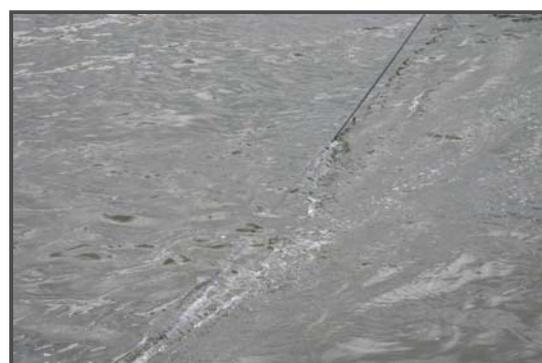
Stahlseile an der Wasseroberfläche zur Befestigung von schwimmenden Anlagen wie z.B. Schiffsanlegern oder Arbeitspontons.
