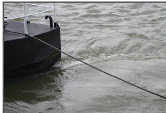
Strömungsverhältnisse am Schiffsanleger: Verwirbelungen stromabwärts.
