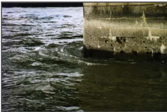
Wasserstau oberhalb von einem Brückenpfeiler.
