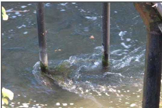
Verwirbelungen am Brückenpfeiler: Hier am Beispiel eines sehr schmalen Pfeilers. Die auftretenden Effekte sind aber an großen Pfeilern identisch.
